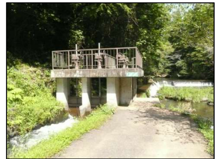
<写真 24: 用水の調整口>
