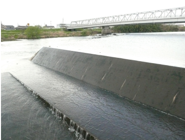
<写真 44：白川薄場橋下の堰>
